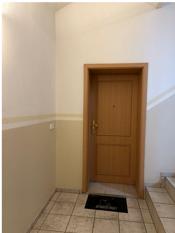
Abb. 07 Teilansicht Treppenhaus im 1.OG mit Blick auf die Eingangstür zu Wohnung Nr. 3
