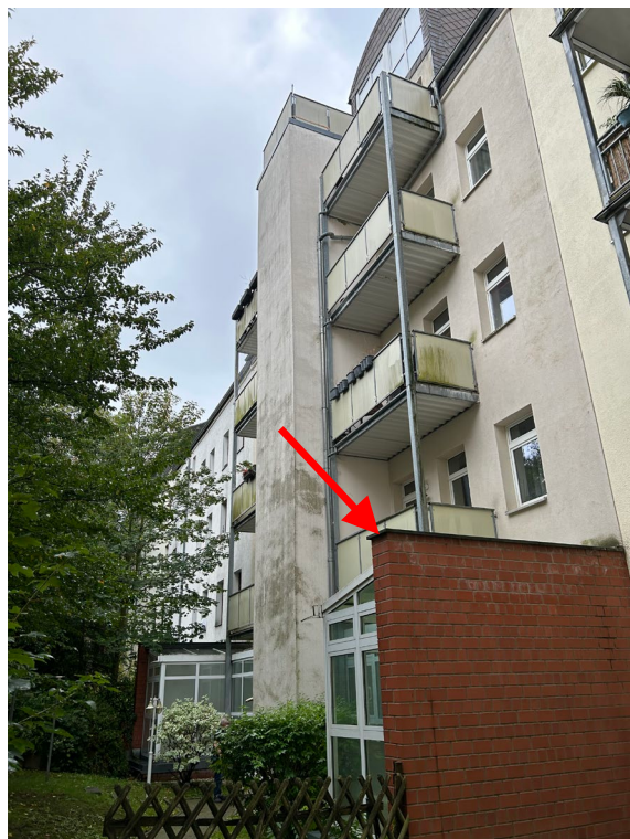
Abb. 03 Teilansicht der Gebäuderückseite und Lage der Wohnung Nr. 3 im 1.OG, Nordwesten
