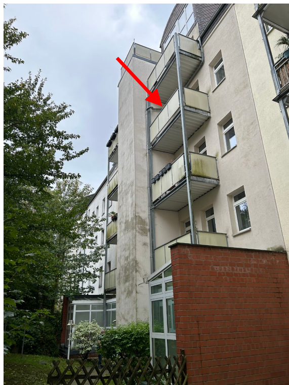
Abb. 03 Teilansicht der Gebäuderückseite und Lage der Wohnung Nr. 7, Nordwesten
