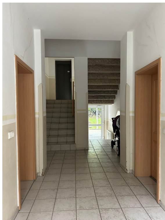
Abb. 06 Teilansicht Hausflur Erdgeschoss, Blick auf die Geschosstreppe und Ausgang zum Garten
