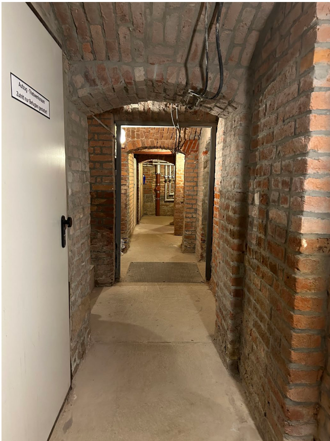
Abb. 10 Kellergeschoss, Teilansicht Kellergang
